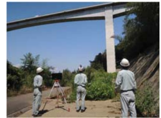
作業状況全景
