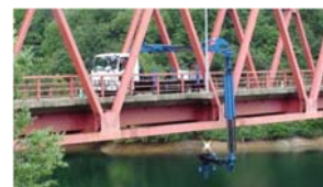
橋梁下面点検
