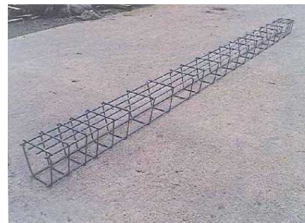
消雪用ブロック用の鉄筋かご
