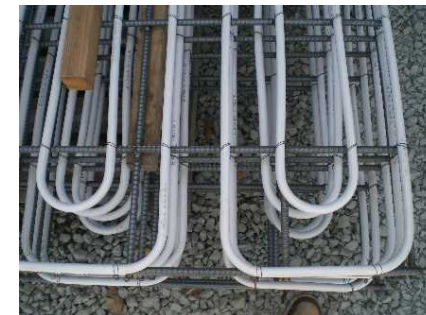
無散水融雪装置(曲げ加工部)
