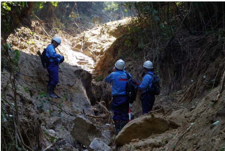
写真2 溪流緊急点検実施状況
