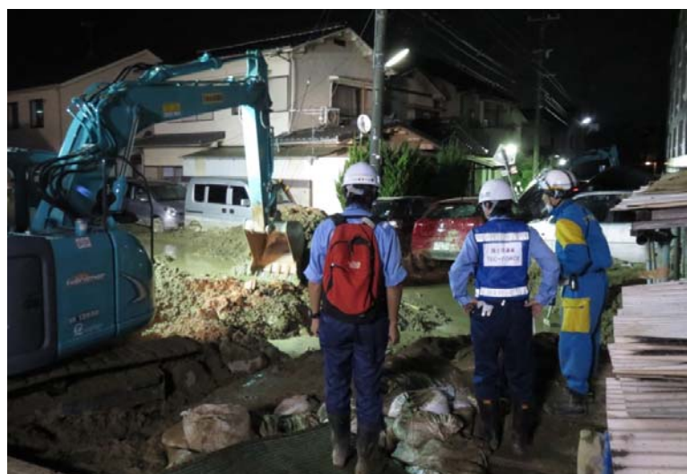
写真5 土砂撤去作業状況
