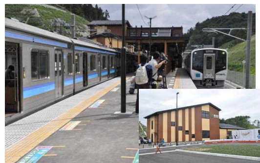
仙石線 復旧後:野蒜駅
