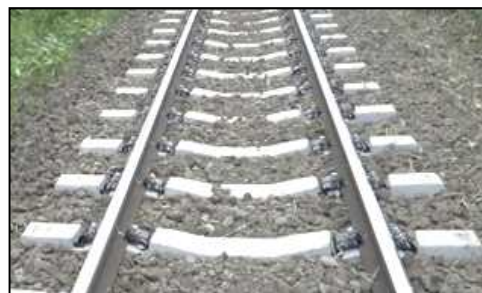
軌道のPCマクラギ化
