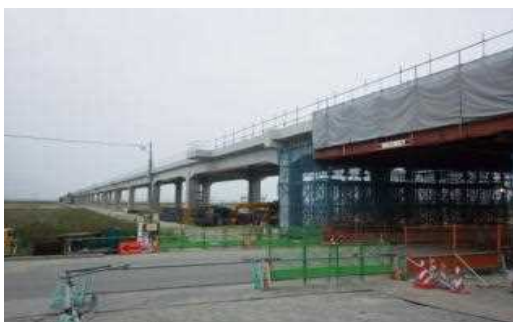
常磐線 復旧工事(山下～浜吉田)
