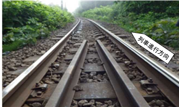
幸連川橋りょう終端(33k171m付近)より札苅駅方
