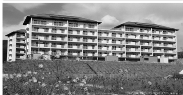
共同住宅形式の災害公営住宅（岩手県陸前高田市・120戸）
