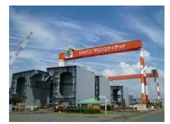
大型クレーン導入による工期短縮
