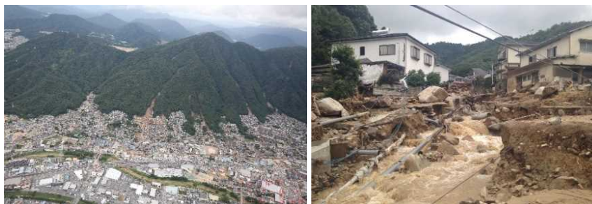
25 ▲平成 26 年 8 月豪雨による広島土砂災害の被害の様子
