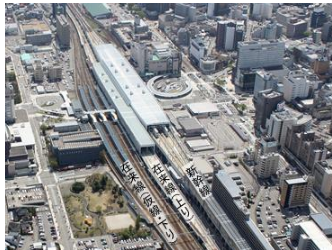
【富山駅付近連続立体交差事業】
