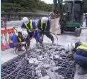
▲修繕・耐震補強
