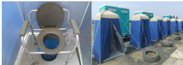
宮城県東松島市で活躍したマンホールトイレ
