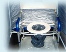
写真左：宮城県東松島市で活躍したマンホールトイレのテント内の上部構造物
