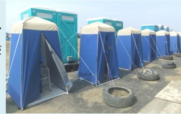
写真上：宮城県東松島市で活躍したマンホールトイレ
