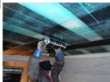
炭素繊維シート接着状況
