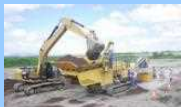
新規制定工種「安定処理工(自走式土質改良工)」
