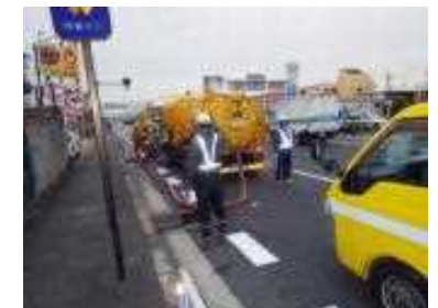
管渠清掃作業
