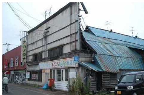
現地写真(上:再開発前、下:再開発後)
