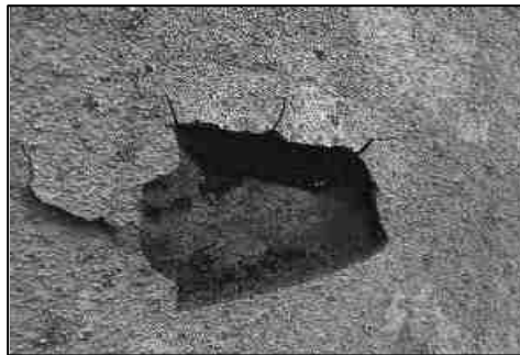
防水押さえコンクリートの損傷
