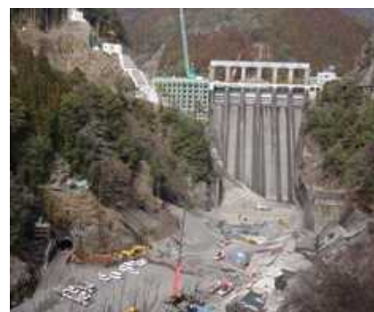
写真2 長安ロダム改造事業 (徳島県那賀町)
