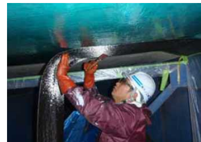
写真9 橋梁の修繕状況
