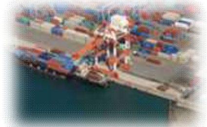
写真5 松山港国際物流ターミナル (愛媛県松山市)
