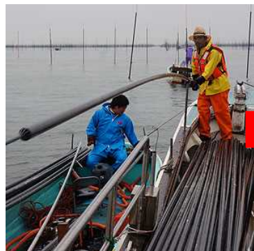
支柱の 積み込み
