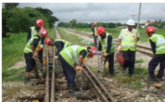
バラスト突き固めによる保守作業 (ヤンゴン＝バゴー間)
