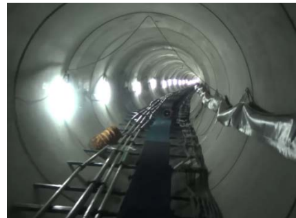
チウリン川放水路建設事業 （インドネシア・ジャカルタ）
