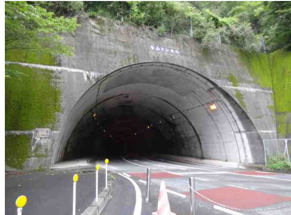
【青山トンネル】
