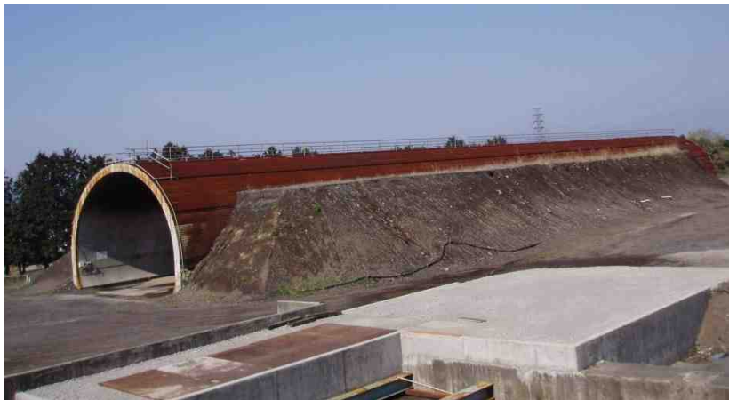
【模擬トンネル】
