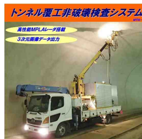
トンネル覆工内部調査 (レーダ計測)
