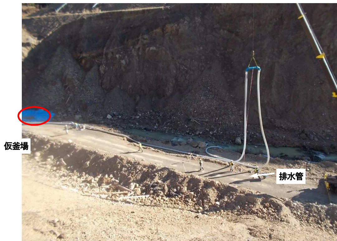
排水作業 現場検証状況
