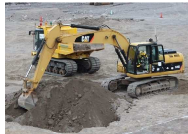
掘削・積込作業状況
