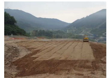
自律制御による転圧作業状況
