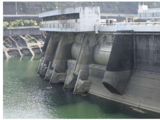
ダム堤体上流面の状況 (EL. 68.6m付近)
