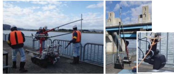
自走式運搬機による水中中部測定イメージ
