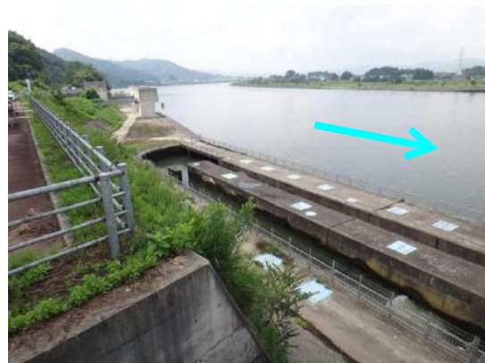
右岸擁壁～魚道の状況 （堰直上流右岸側より）
