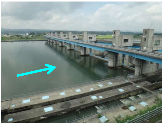
妙見堰全景 （堰直上流右岸側より）
