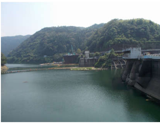
ダム湖の状況 (堤体直上流付近)
