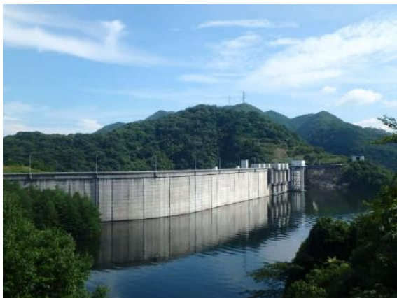
ダム湖の状況 (堤体直上流付近)
