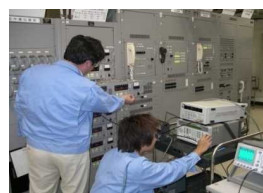
(航空保安施設点検実施状況)
