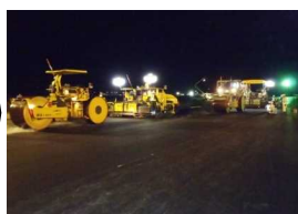
(老朽化した滑走路舗装の改良)
