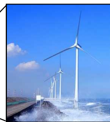
洋上風力発電施設
