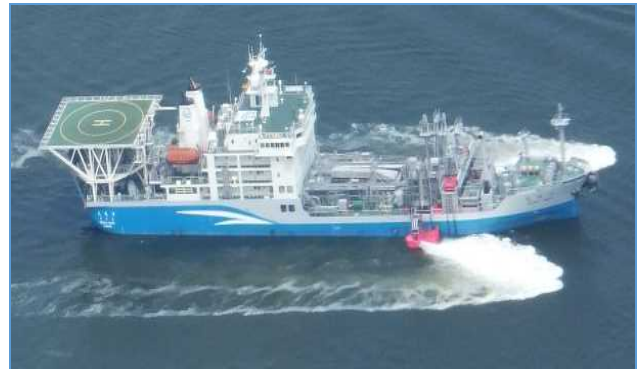
大型浚渫兼油回収船 清龍丸（せいりゅうまる） ＜中部地方整備局所管＞
