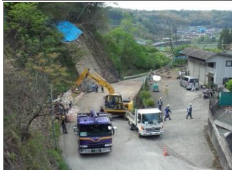
TEC-FORCEによる応急復旧作業状況
