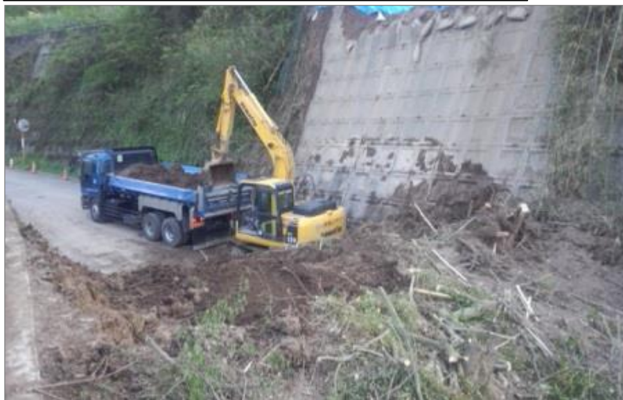
TEC-FORCEによる応急復旧作業状況
