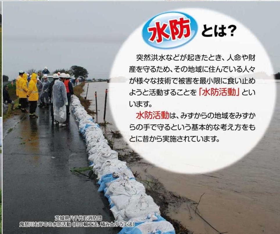
茨城県八千代町消防団 鬼怒川右岸での水防活動(月の輪工法、積み土のう工法)
