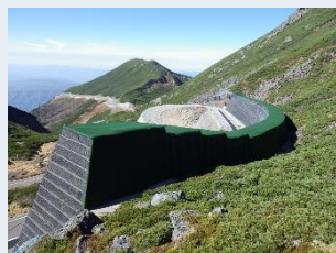
写真-2 国定公園内 施工事例 岐阜県飛騨市乗鞍スカイライン
