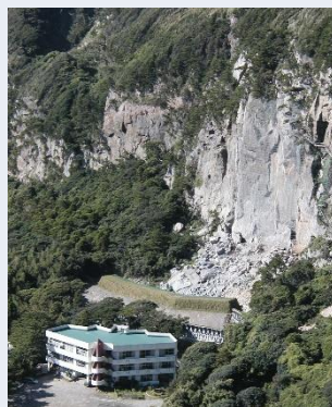
写真-1 大規模落石(岩盤崩落)補足事例 東京都新島村
