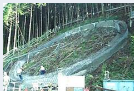
リングビーム施工状況
