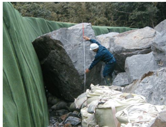
写真一 3 落石捕捉 事例
