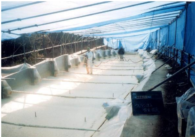
写真一 1 施工状況
