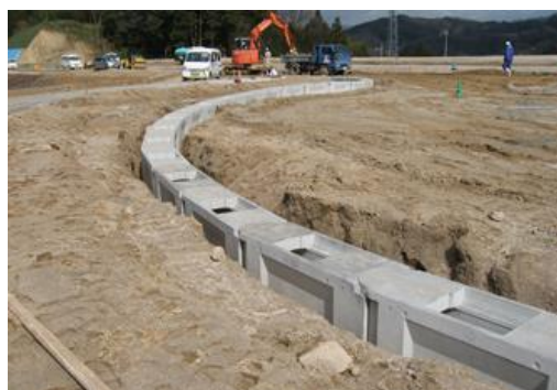
写真二 施工状況
