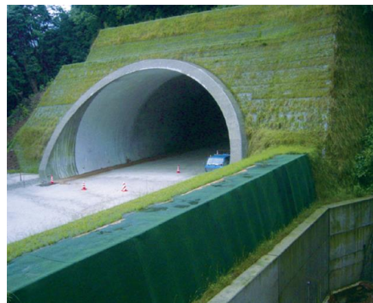
写真一 1 トンネル坑口 事例
