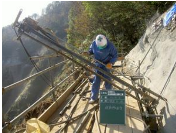
単管足場による施工状況(ベンチャードリル使用)
