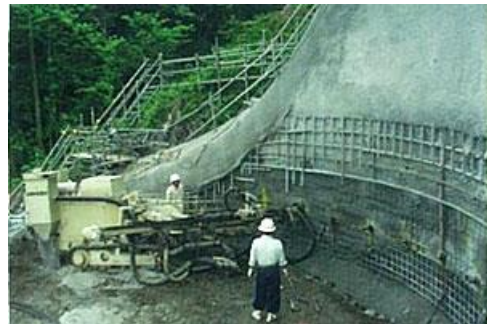
写真-2 ロックボルト打設状況
