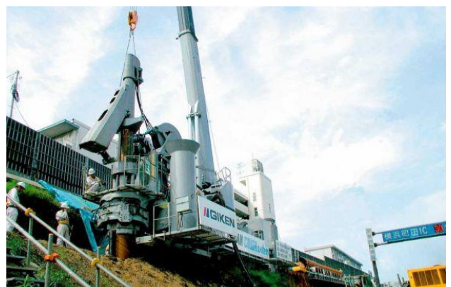
写真-3 斜面での施工事例
