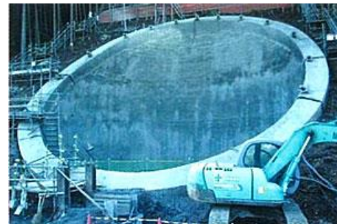
写真-4 吹付けコンクリート完了
