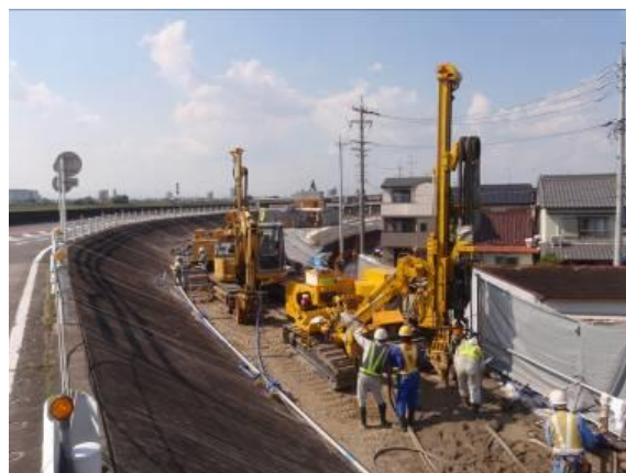
写真—2 SAVE-SP 工法施工状況
