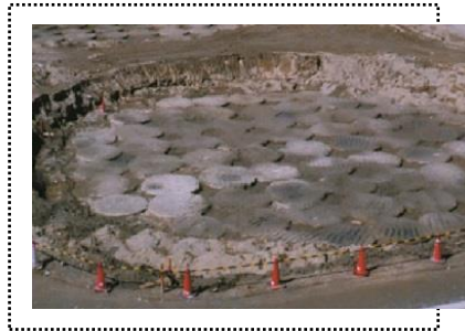
写真一 タンクの基礎
