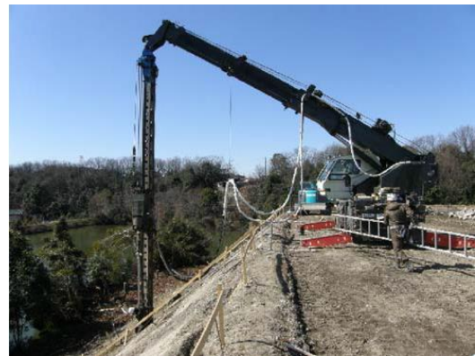
写真一2 傾斜地における施工例
