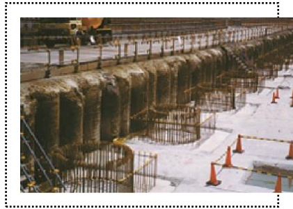
写真一 自立山留壁
