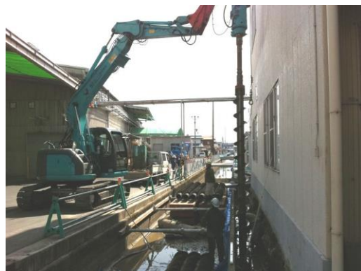
写真一3 重機が寄り付かない箇所の施工例
