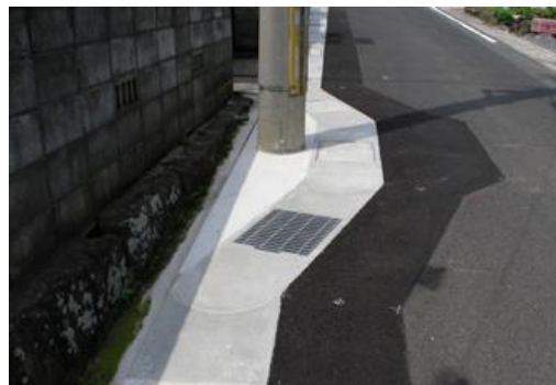
写真六 電柱回避
