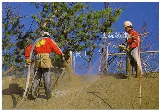
写真一 連続繊維補強土の施工状況○○○○
