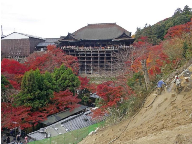
復旧工事の施工状況（平成 25 年の崩壊）
