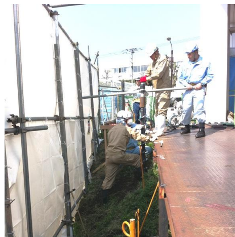
写真一4 重機が入れない場所での人力施工例
