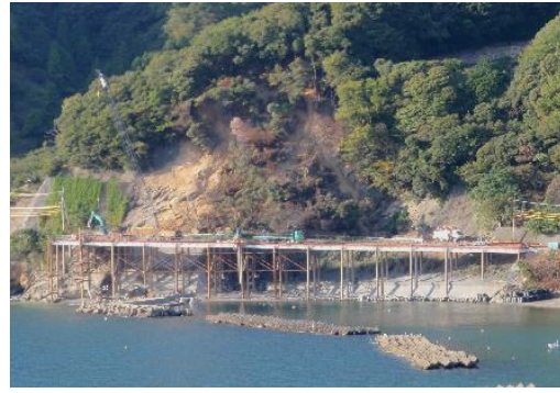
写真二 災害復旧時の手延べ式応急組立橋 (法面崩落による集落孤立を解消)
