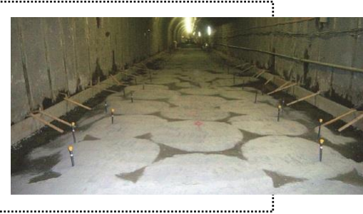
写真一 トンネル安定対策
