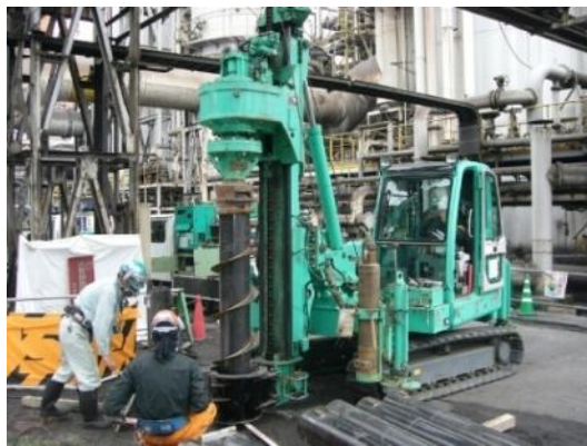
写真一1 小型杭打機による施工例
