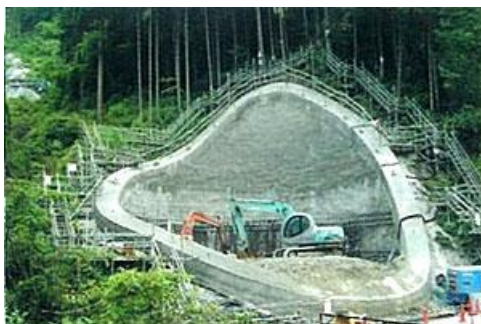
写真-3 掘削状況
