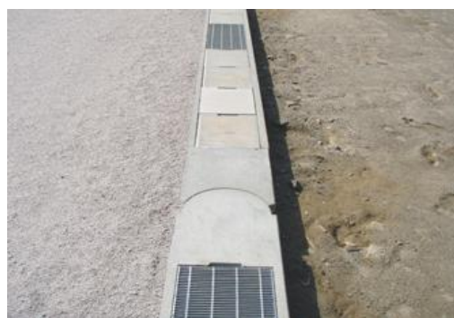
写真八 道路用側溝との組合せ
