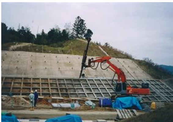
バックホウドリルによる施工状況
