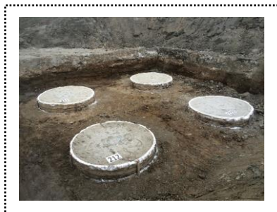
写真一 盛土の沈下対策
