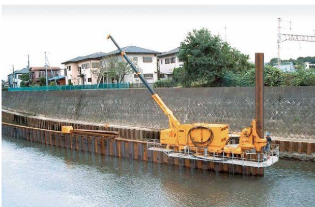
写真-2 水上での施工事例
