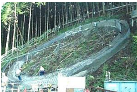
写真-1 リングビーム施工状況
