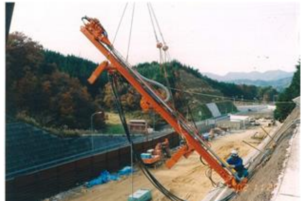
クレーン吊り上げによる施工状況
