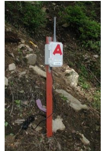
写真-2 斜面崩壊検知センサーの設置状況
