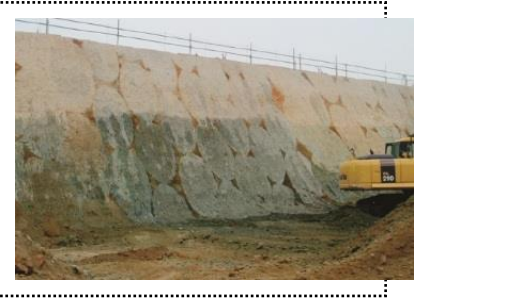
写真一 地山安定対策
