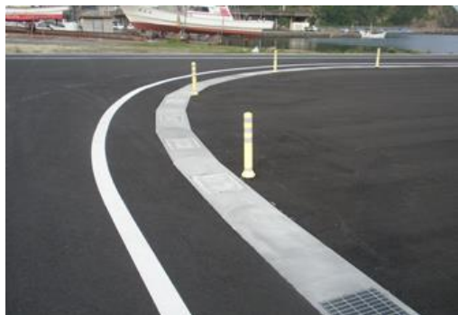
写真五 カーブ施工
