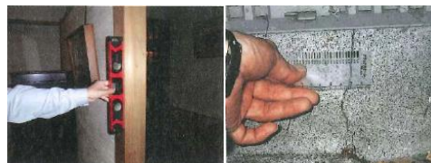
左図：水平器による柱の傾きの計測 右図：クラックスケールによる基礎のひび割れ幅の計測
