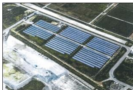
図表 光陽地区メガソーラー (相馬光陽発電所)
