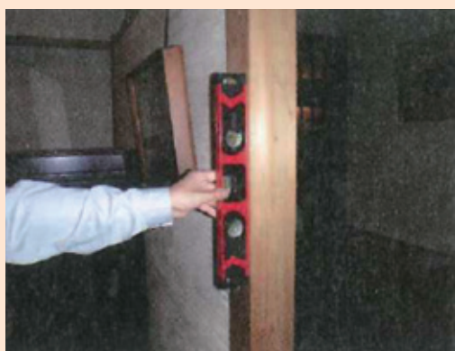
水平器による柱の傾きの計測
