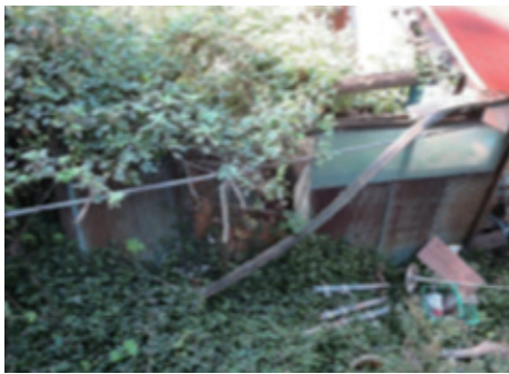
略式執行前の建物の状況
