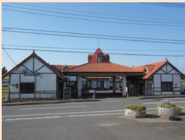
図表3-1-20 空き公共施設の活用例（農業生産法人による農産物直売所等の活用）
