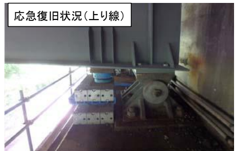
ゆふだけ 由布岳PA付近 並柳橋 桁及び支承損傷
