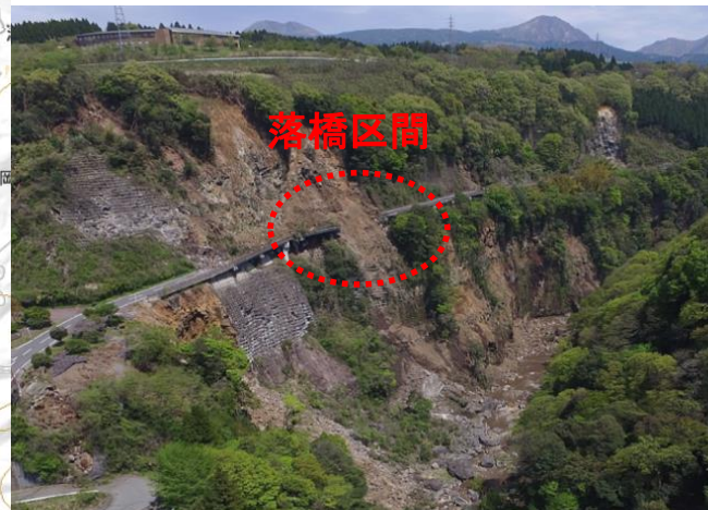
戸下大橋の被災状況
