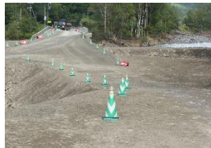
工事用道路施工
