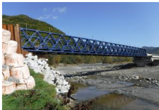
仮橋架設完了
