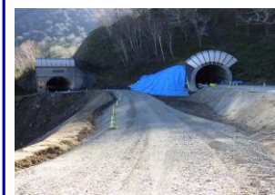
工事用道路施工
