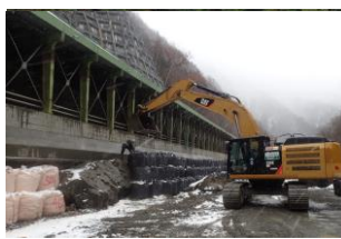
応急復旧作業
