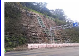
応急復旧作業
