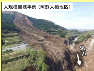
多様な土砂移動現象が発生
