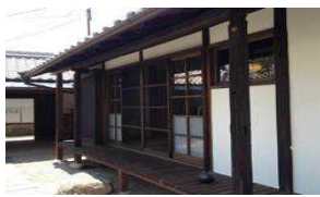
古民家を宿泊施設に改装して運営 (明日香村おもてなしファンド)
