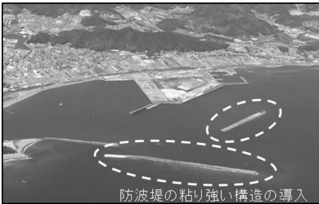
粘り強い構造の防波堤の整備事例：高知港
