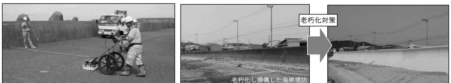
長寿命化計画策定に必要な空洞化調査の事例
