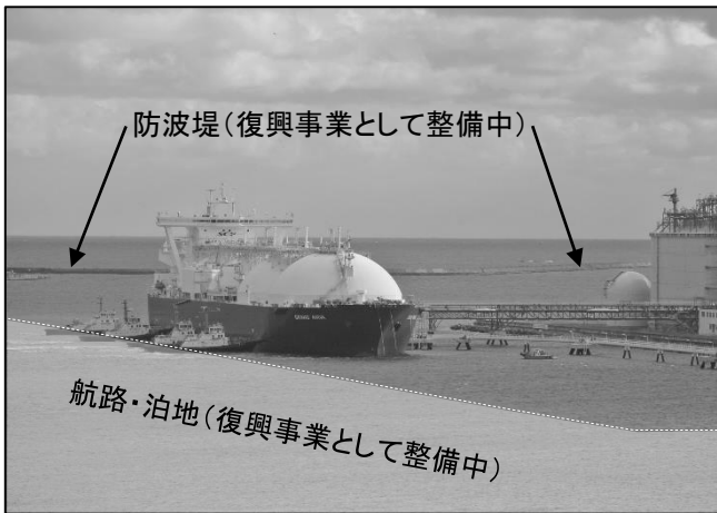
八戸港LNG輸入ターミナルの利用状況 (平成27年4月供用)
