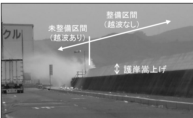
護岸嵩上げによる防護効果：下関港海岸
