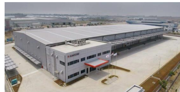
我が国港湾関係事業者が新設した物流施設(インドネシア)
