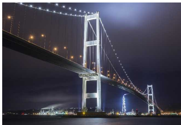
室蘭夜景観光として親しまれている白鳥大橋のイルミネーションライトアップ LED化(H29年度完了予定)
