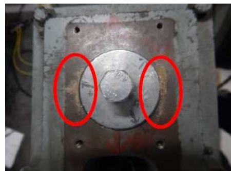
(b) 摩耗粉の落とし込み箇所
