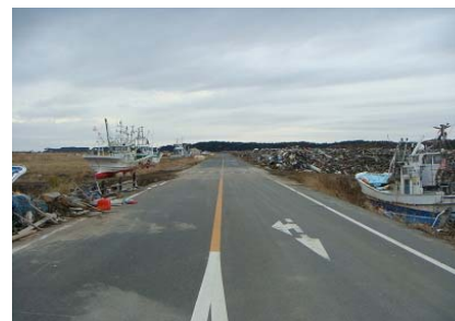
撤去前(平成26年7月)
