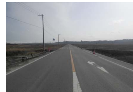
撤去後(平成28年3月)
