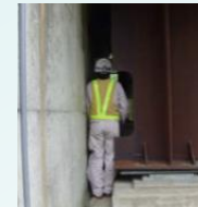
支承交換や桁端点検の空間なし
