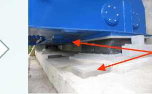
支承交換が容易な構造の例
