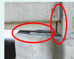
支承交換や桁端点検の空間なし
