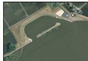
既設の堤防を陸側に作り直し、湖水を引き込みワンドを整備しました。(平成25年度完成) 今後は水際部の植生繁茂が期待されています。
