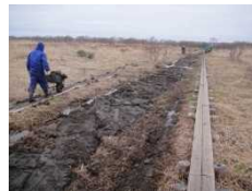
水抜き水路の埋め戻し
