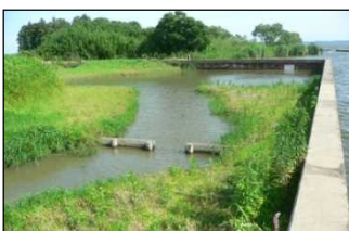
既設の矢板を一部撤去し、陸地に湖水を引き込み、ワンドを整備しました。(平成19年完成) 現在水際部の植生が繁茂し、環境学習の場として活用されている。
