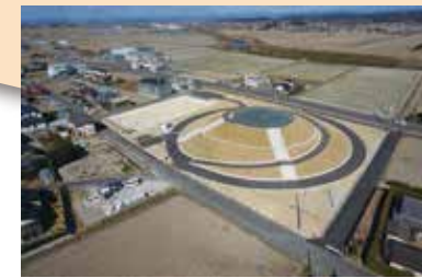
平時は地域のコミュニティ施設として機能しつつ、津波の災害時には避難場所となる命山 (静岡県袋井市)
