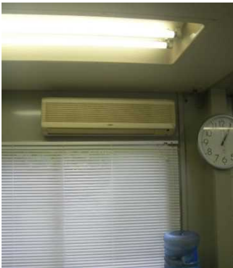
▲エアコン設置
