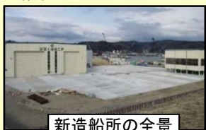
新造船所の全景
