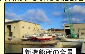
新造船所の全景
