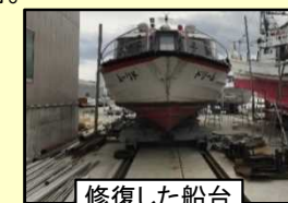
修復した船台
