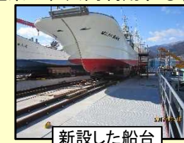
新設した船台
