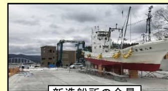
新造船所の全景
