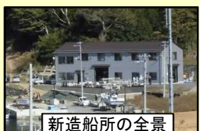
新造船所の全景
