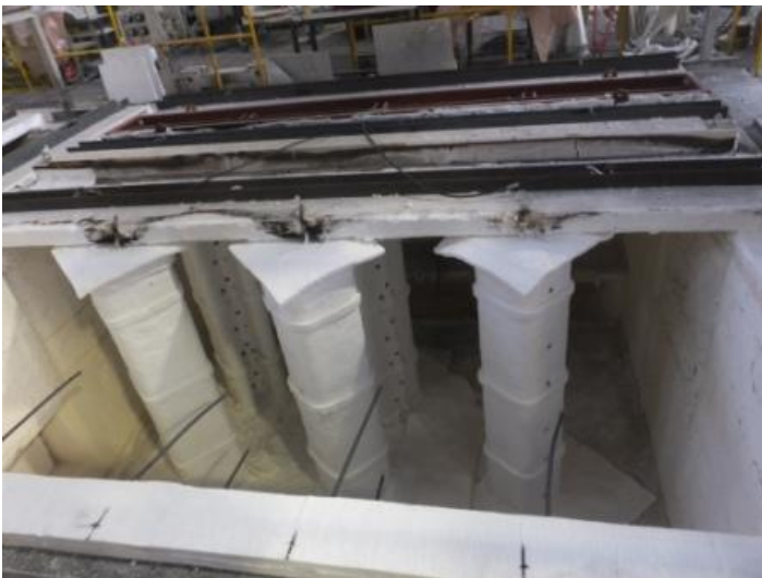
中規模試験の状況
