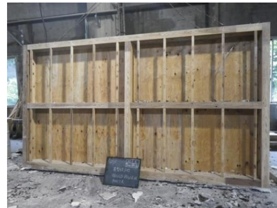
解体後の試験体 (野縁表面)
