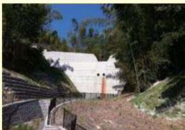
城山沢(砂防えん堤)
