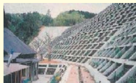
堂ノ本区域(急傾斜地崩壊防止施設)
