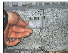
基礎のひび割れ幅の計測
