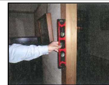
水平器による柱の傾きの計測
