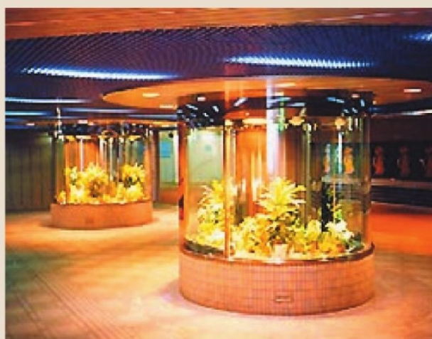
—光ファイバーを通じた自然光の取込み— (愛知県豊橋市駅前地下横断歩道)
