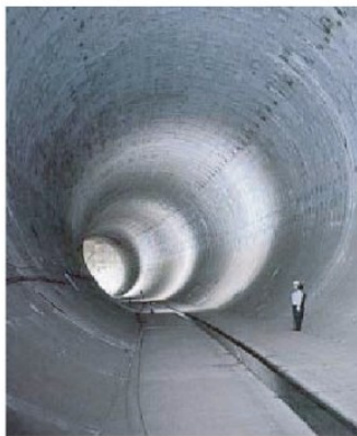
▲神田川・環状七号線地下調節地
