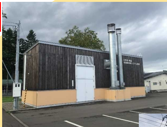
下川町・チップボイラー
